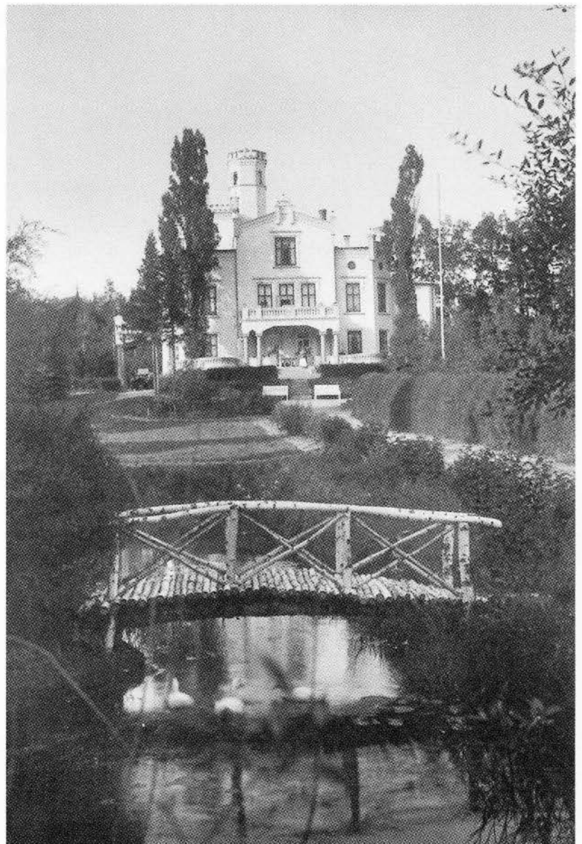
Hovedbygningen på Ask gods sett fra parken. Godset ligger nord for Hønefoss på Ringerike.
