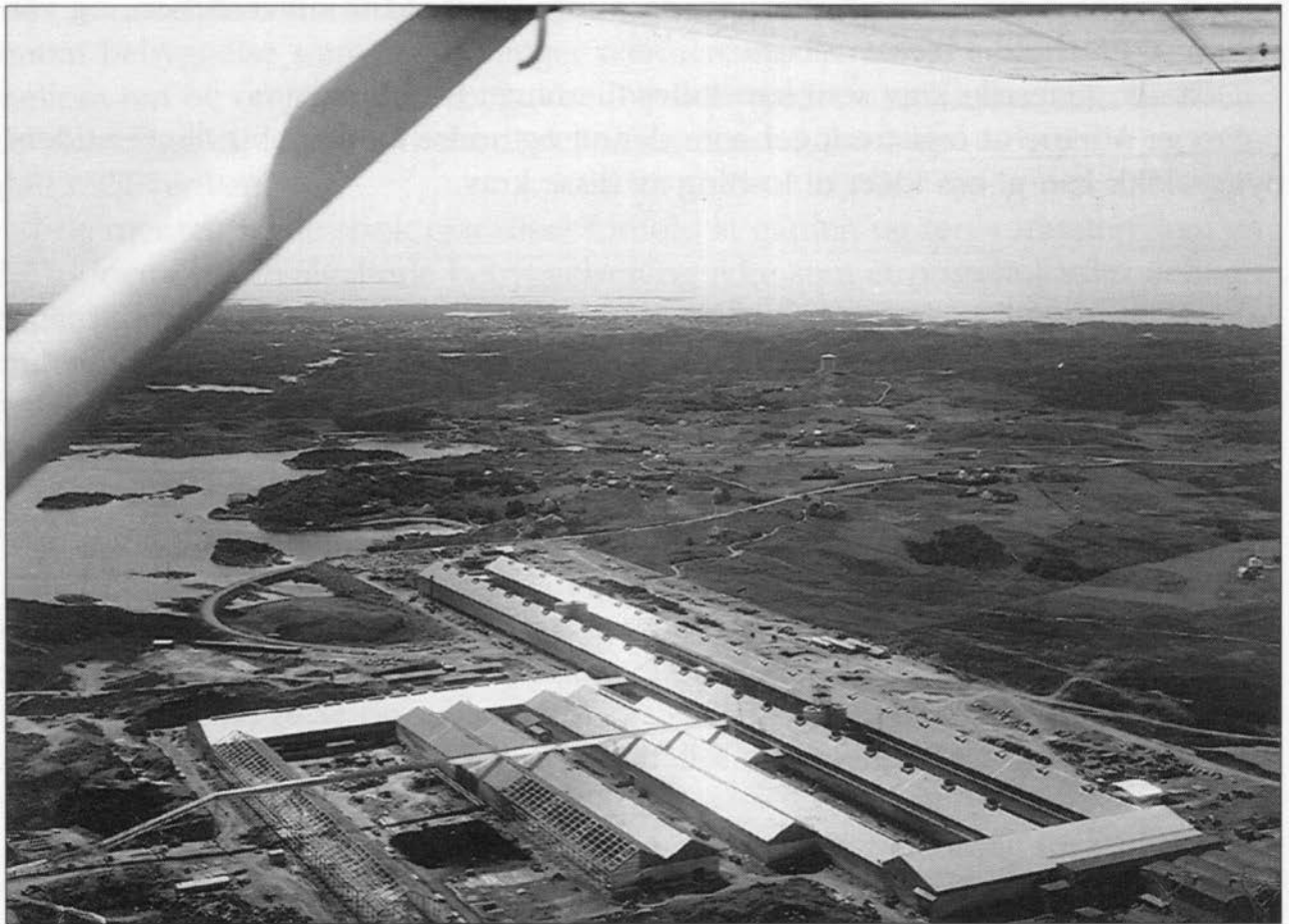
Alnor - anlegget på Håvik sett fra luften den 20. juni 1967 (Foto: Eliassen P. og Strøm, Bj. Aa., Av egen kraft, Hgsd. 1989).
