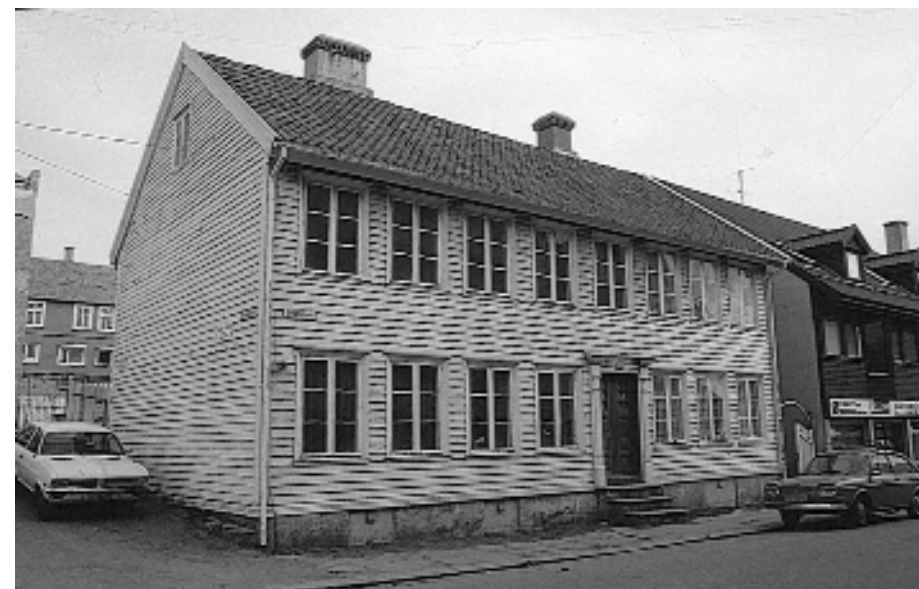
Strandgt. 207 er eksempel på senklassistiske byhus tilpasset beliggenheten i kvadraturen. Åpningene er konsentrert om de frie langsiden. Tomten er relativt bred. Det er ett eller flere uthus for dyr og husholdningsfunksjoner på gårdsplassen bakenfor.
