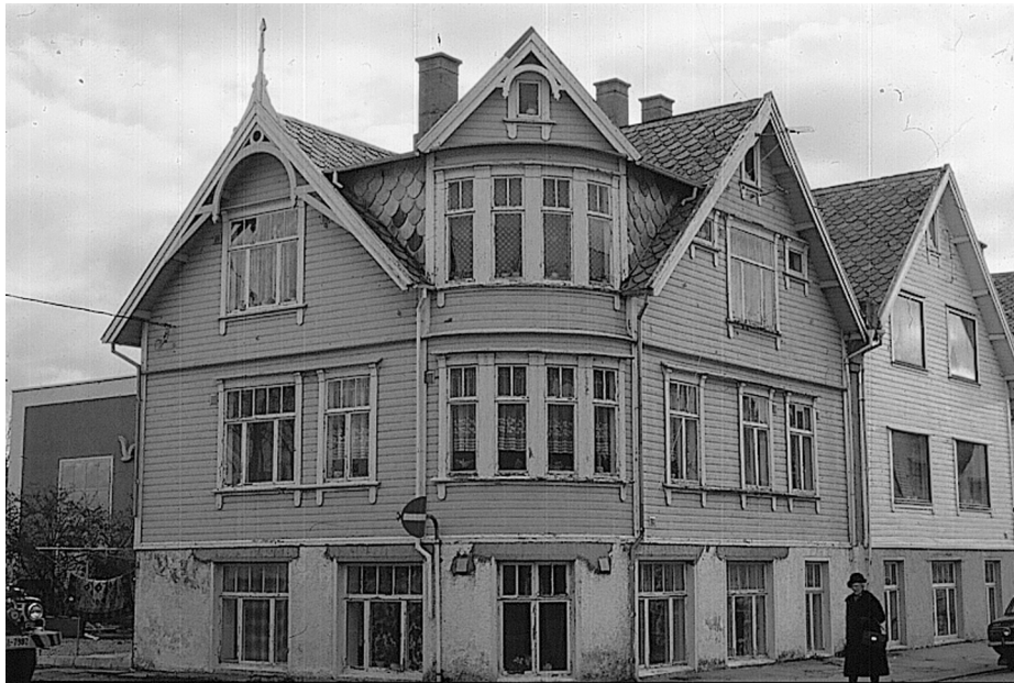
Hjørnehus med tårnløsning ble alminnelige i Haugesund allerede fra 1890-årene. Men jugendstilens hjørneløsninger er gjerne mest originale i en større sammenheng. Båndene av sidestilte smale vinduer i buefronten ivaretar inntrykket av tårn. Men både bygningens eksterior og rommene innenfor virker som samlede volumer. Kombinasjonen av vinduer øverst i gavlen t.h. er et lokalt motemotiv. Her: Flotmyrgt. 189.
