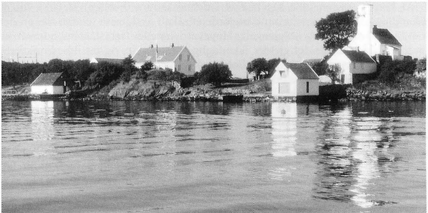
Bygningsmiljøet på Høyevarden sett fra sjøsiden. Foto: Norsk Hydro.
