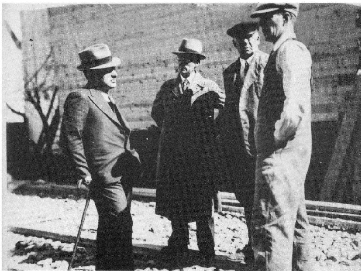
Under byggingen av CONDOR. Fra venstre: M. Rabinowitz, arkitekt Steensnæs, byggmester Helgesen og murmester Johannesen
