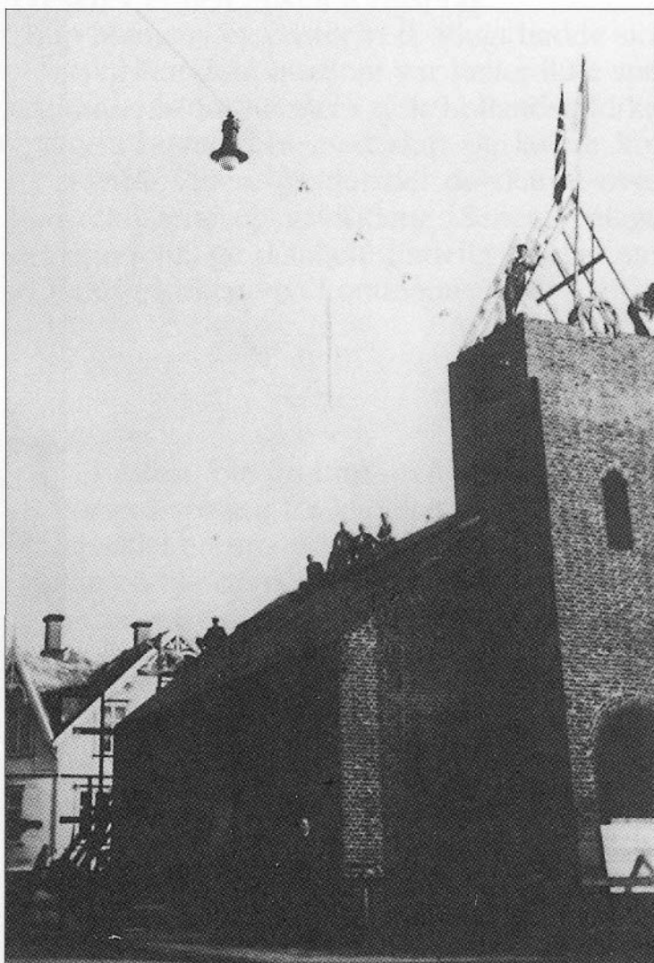
Pastor v.d. Vlugt fikk selv legge sluttsteinen i korbuen. Leveringen av taksperrere forsinket byggearbeidet. Men da de var reist, ble det holdt kranselag.
