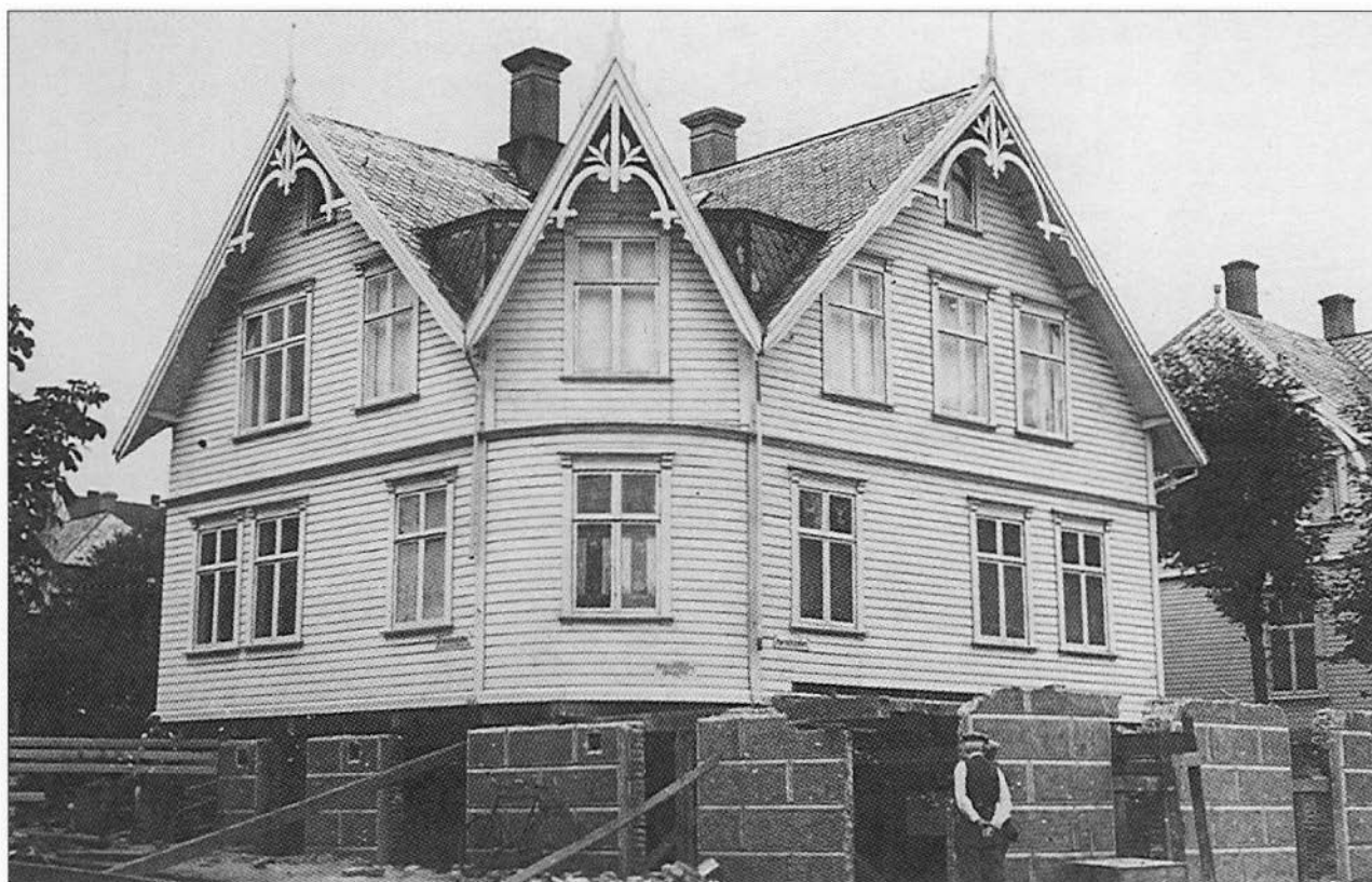
Arbeidet med å flytte presteboligen varte halvannen måned og skjedde uten ubell av noe slag. Stein fra den murte underetasjen ble brukt i kirkebygget. På bildet nederst er fundamentet for tårnet lagt. Litt av murverket fra presteboligen står enda.
