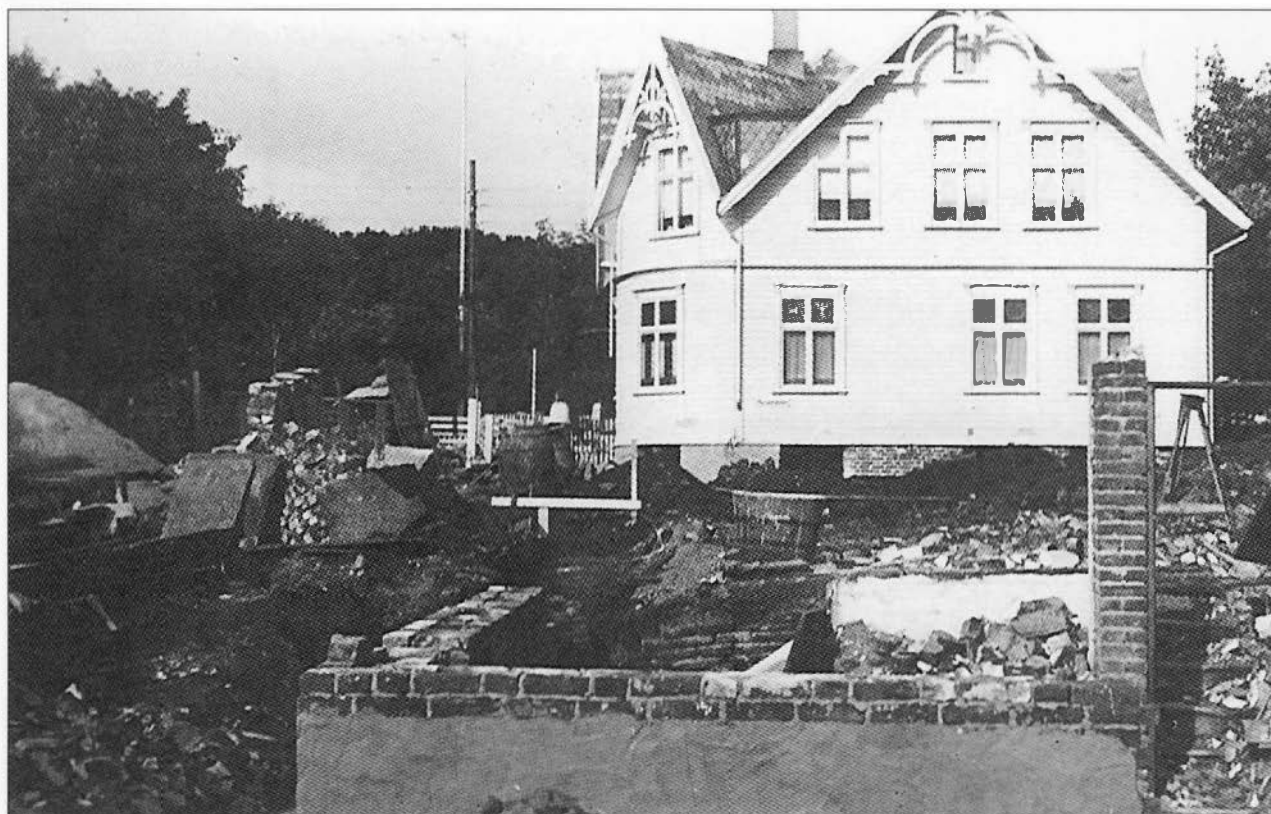
Arbeidet med å flytte presteboligen varte halvannen måned og skjedde uten ubell av noe slag. Stein fra den murte underetasjen ble brukt i kirkebygget. På bildet nederst er fundamentet for tårnet lagt. Litt av murverket fra presteboligen står enda.
