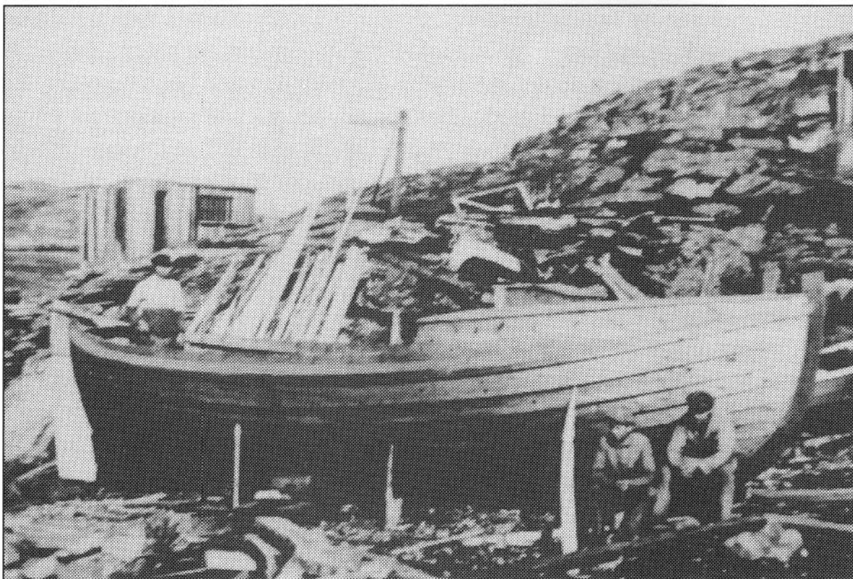
Motorbåt under bygging på Lyngholm i 1936.
