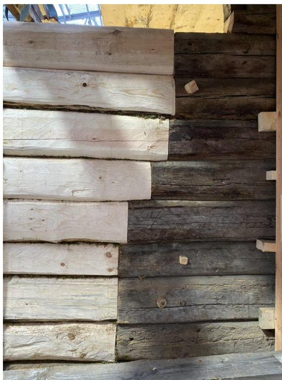
*Figur 9 Restaureringa av Derikhuset, Skudeneshavn er eit av dei større prosjekta Haugalandmuseet starta opp i 2022. Bygningen restaurerast etter antikvariske prinsipp og det er sett opp eit tak-over-tak-stillas slik at arbeidet kan gå føre seg uavhengig av vêr og vind. Foto: Haugalandmuseet*
